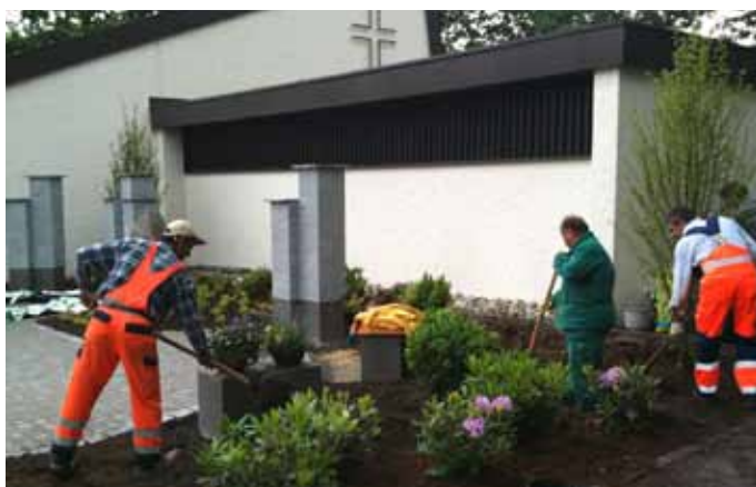
Die Bauhofmitarbeiter gestalten den Friedhof
