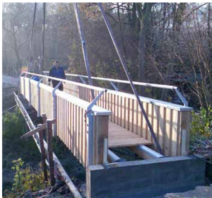
Der neue Steg wird auf seine Fundamente gesetzt
