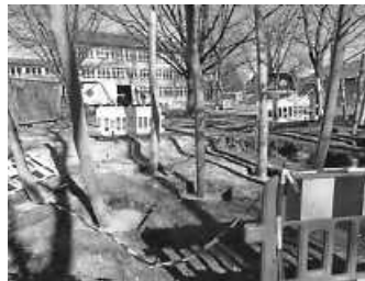
Der Niedrigseilgarten wird vorbereitet
