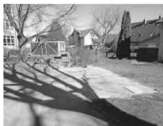
Das Fundament für den Lagercontainer ist vorbereitet
